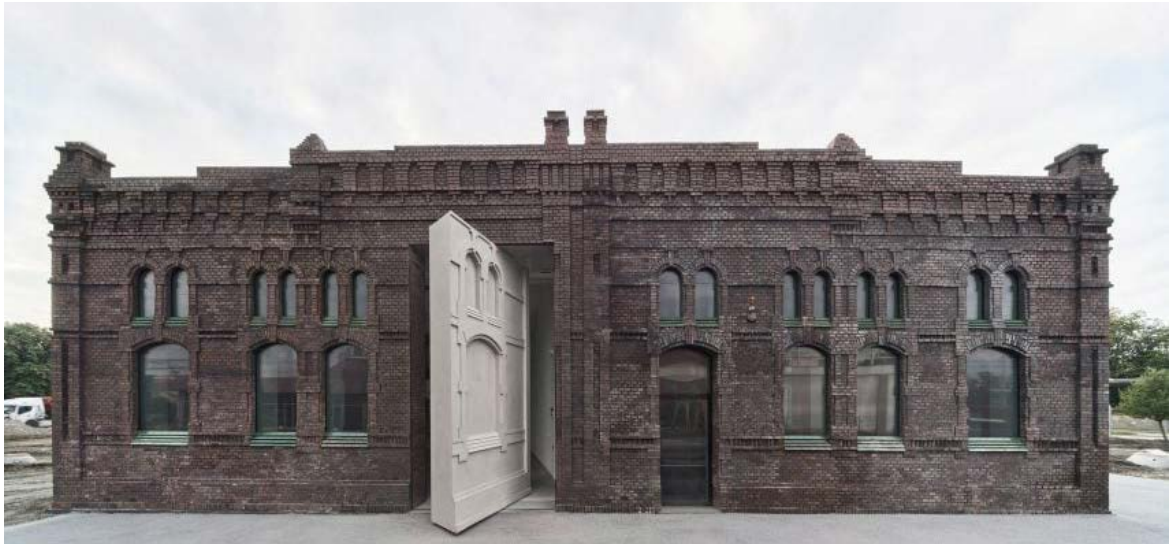
Zes grote roterende wanden openen de Plato Contemporary Art Gallery in het Tsjechische Ostrava naar het omliggende park.
