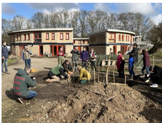
'Ecodorpers' aan het werk bij de aanleg van natuur in het dorp.
