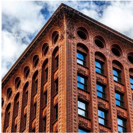
Afb. 3: Louis Sullivan (1857-1924), Guaranty Building, Buffalo (NY) , 1894-1896, stalen skelet, terracotta bekleding en baksteen, hoogte is 51 meter. Realiseert als een van de eersten met behulp van een stalen bouwskelet een kantoorgebouw met dertien verdiepingen. Van Sullivan zou de uitspraak 'Form follows function' zijn.
