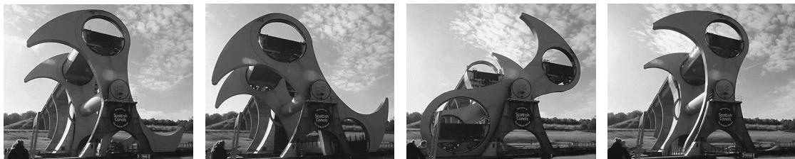
Je ziet een afbeelding van de constructie halverwege de draai. De twee bakken staan dan op gelijke hoogte.
